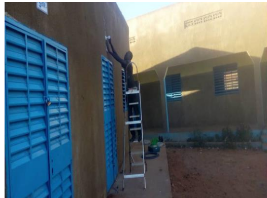
Die Solaranlage im Lycée «Emmaus»
