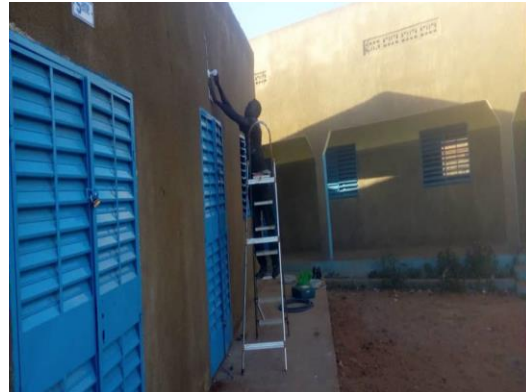
Die Solaranlage im Lycée «Emmaüs»
